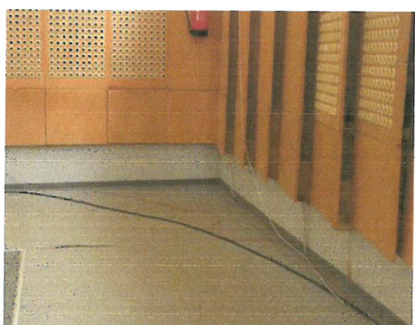
Kábelek a közlekedőben.
