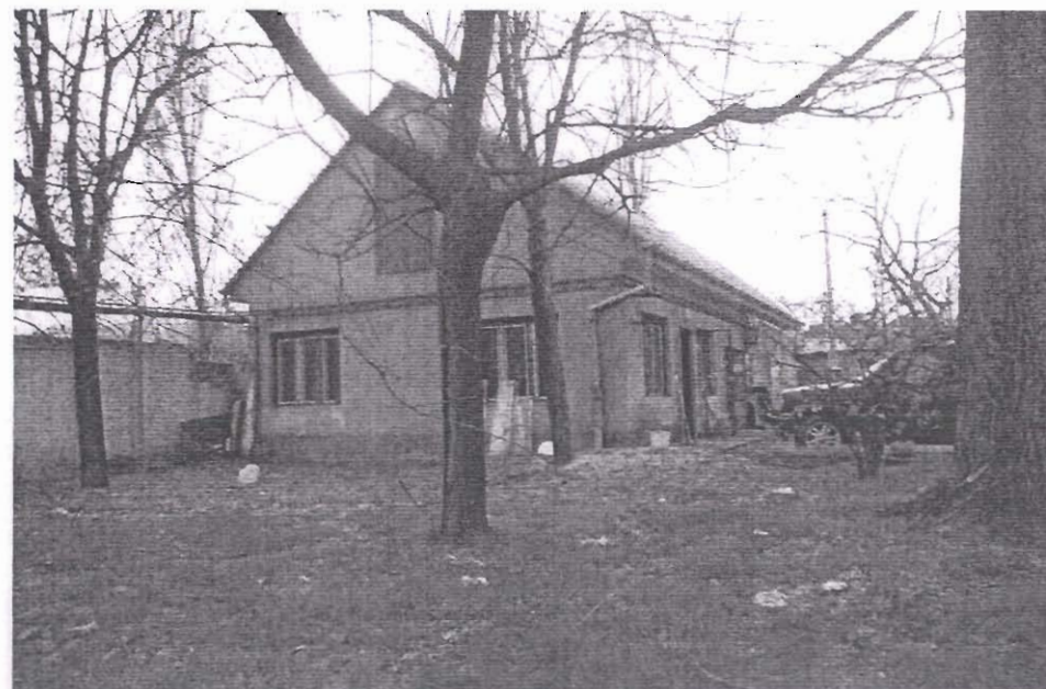
Utcai fronton lévő épület
