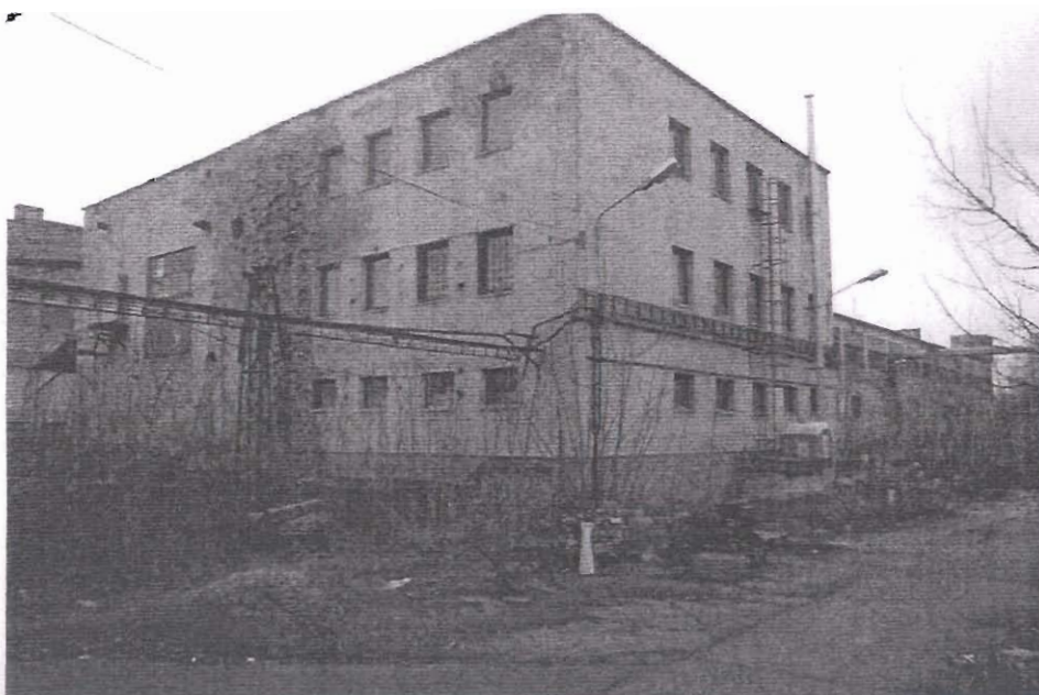
Lezárt üzemi épület látképe
