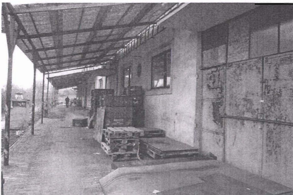
Lezárt üzemi épület rampája
